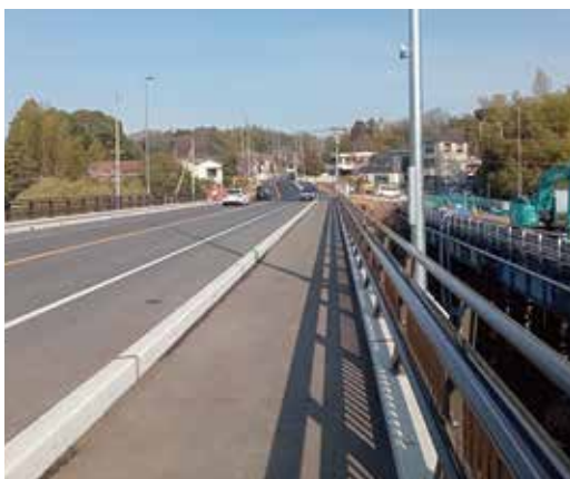
供用開始となり仮橋撤去が行われる柏井橋
