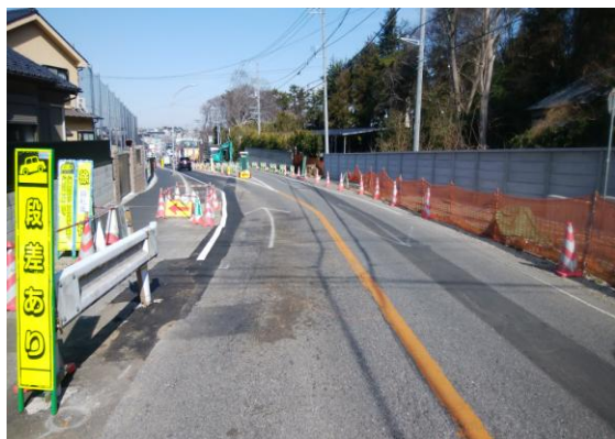
柏井小学校横道路拡幅工事
