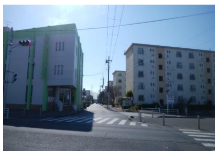
舗装が改善された道路
