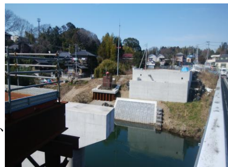
柏井橋架け替え工事
