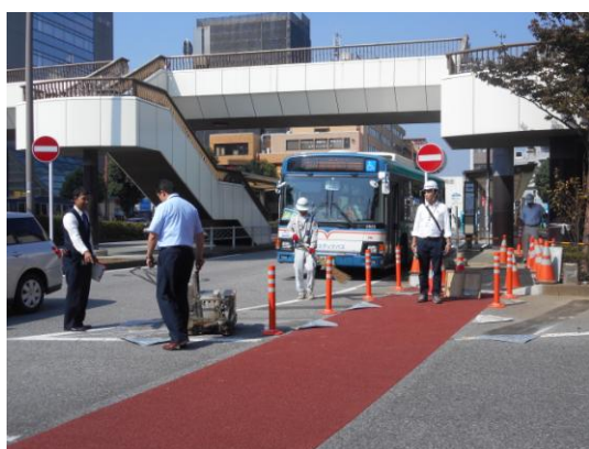
バスターミナルの歩道切り下げ工事
