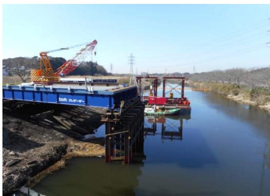
亥鼻橋の仮橋架設工事
