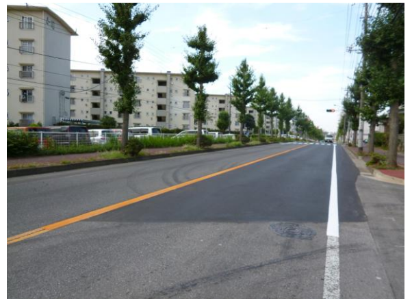
補修された天戸町横戸町線の一部
