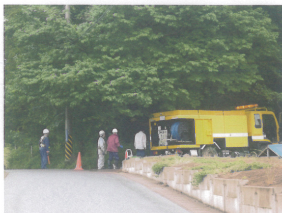
側溝の汚泥除去作業
